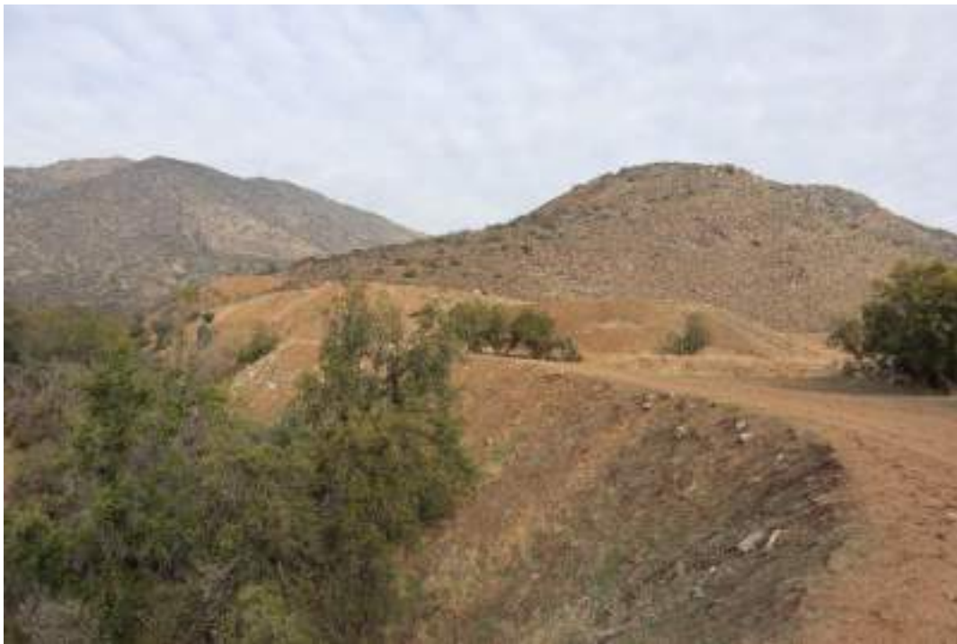
Imagen 16: Sitio de remoción de tierra camino a Morro Las Papas, Parque La Plaza
